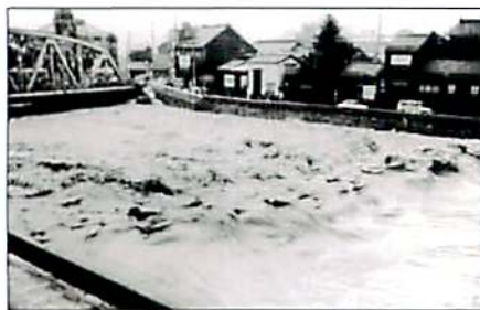
昭和36年(犀川大橋上流)
