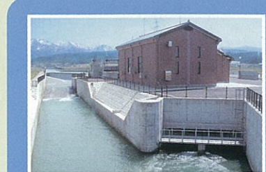
七ヶ用水発電所 農業用水を利用した水力発電所です。
