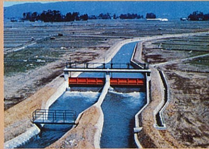
改修直後の的場分水工
