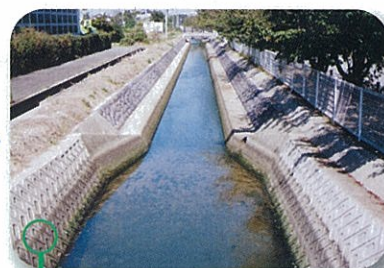
きれいになった水路
